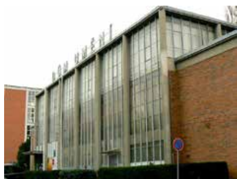
Přístavby budou odstraněny. / foto: MMZ
