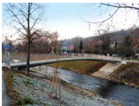
Lávka je hodně využívána. / Foto: MMZ
