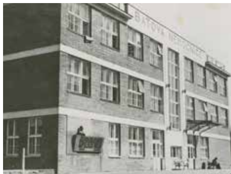
Původní budova nemocnice. / foto: archiv SOkA Zlín
