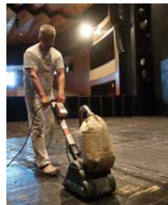
Odstraňování 19 nátěrů. / foto: MDZ
