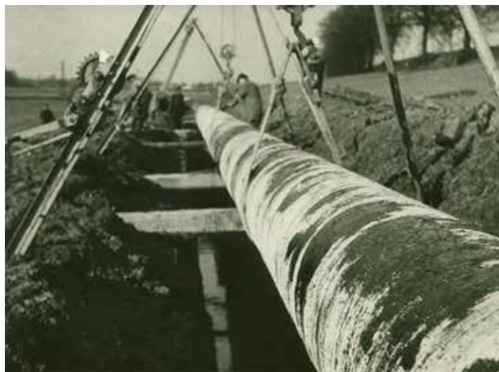
1949 – stavba úpravní vody v Tumačově. / foto: SOKA Zlín
