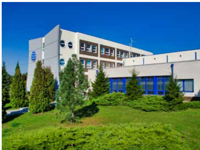
Úprava vody Klečůvka se otevře veřejnosti. / foto: VaK Zlín
