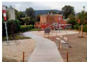
Hřiště po rekonstrukci. / foto: OMZ
