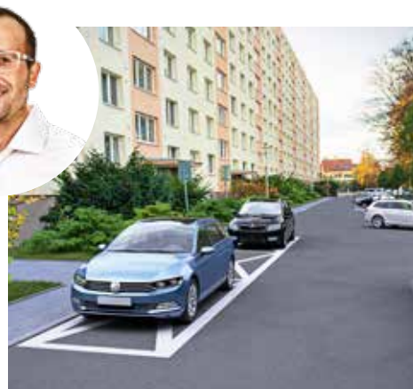
Zrekonstruovaná vozovka u bytového domu
