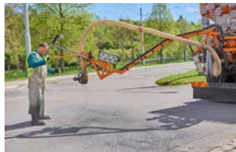
Pracovník TS opravuje cestu pomocí technologie TURBO
